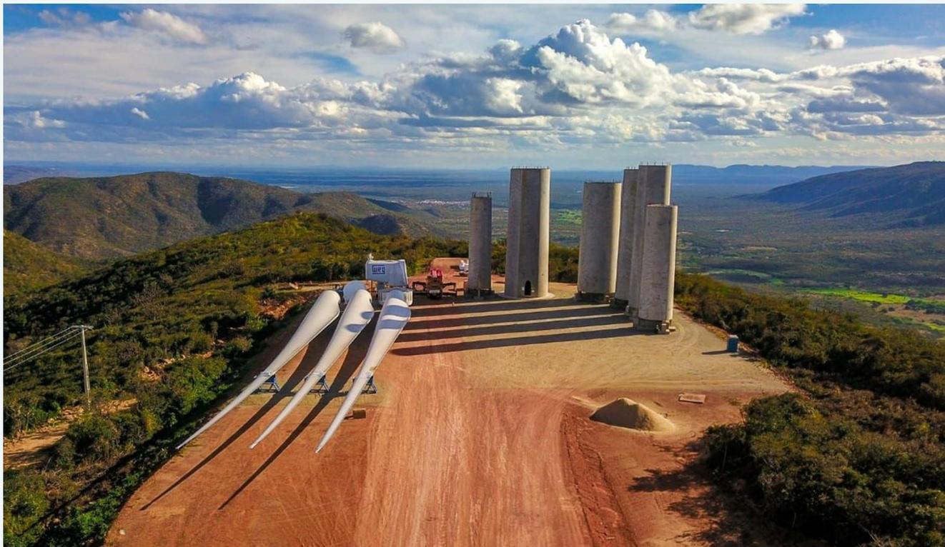
Todos os componentes para montagem do aerogerador WEG no site – torres verticalizadas, nacelle, gerador, hub e pás armazenadas na plataforma
